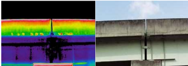
構造物診断(橋梁)
